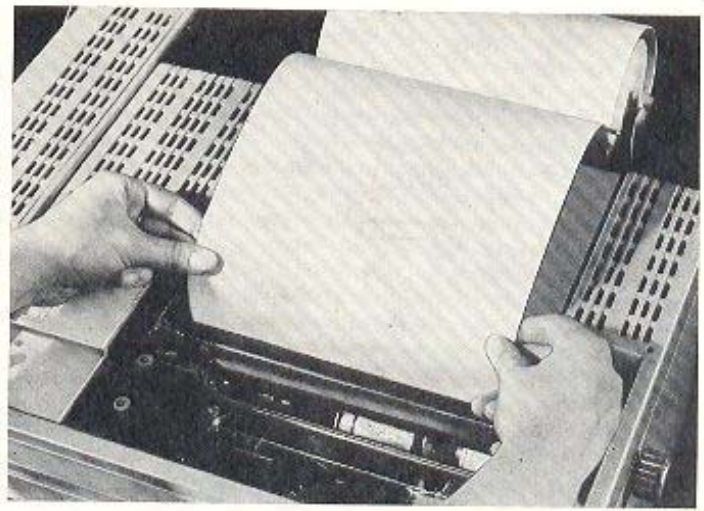
Bild 8 Fernschreiberpapier einlegen
